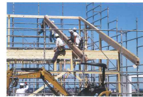
LVL 横架材設置風景
