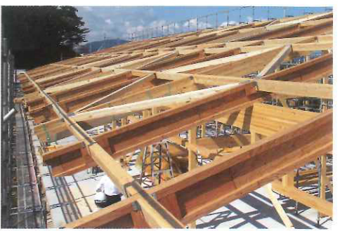
屋根下地組み上がり
