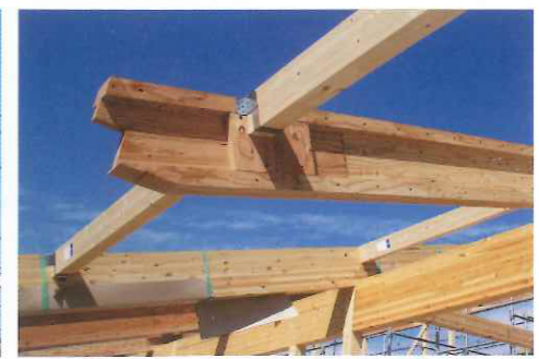
LVL 横架材軒先接合部
